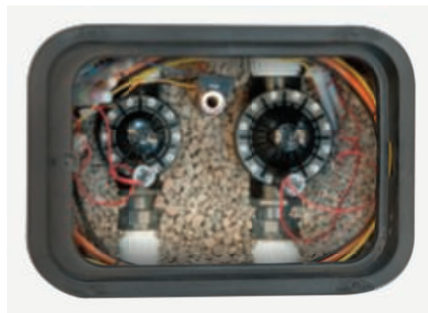
Szerelt PGV mágnesszelepek
